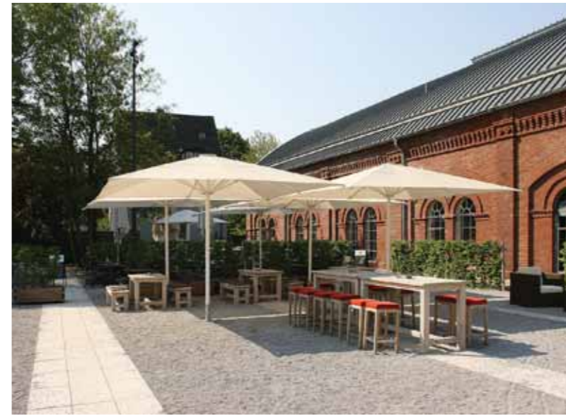
Herzstück ist die Gastronomie, für die 2014 die neue, hochmoderne „Goldküche“ gebaut wurde Fotos: ganz links und ganz rechts: Rohrmeisterei Schwerte; Mitte: Frank Vincentz/Wikimedia Commons
