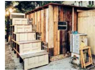
Fahrradschuppen, gebaut von den Architekturstudierenden M. Petzold, J. Bruns, S. Lässig, V. Klaus
