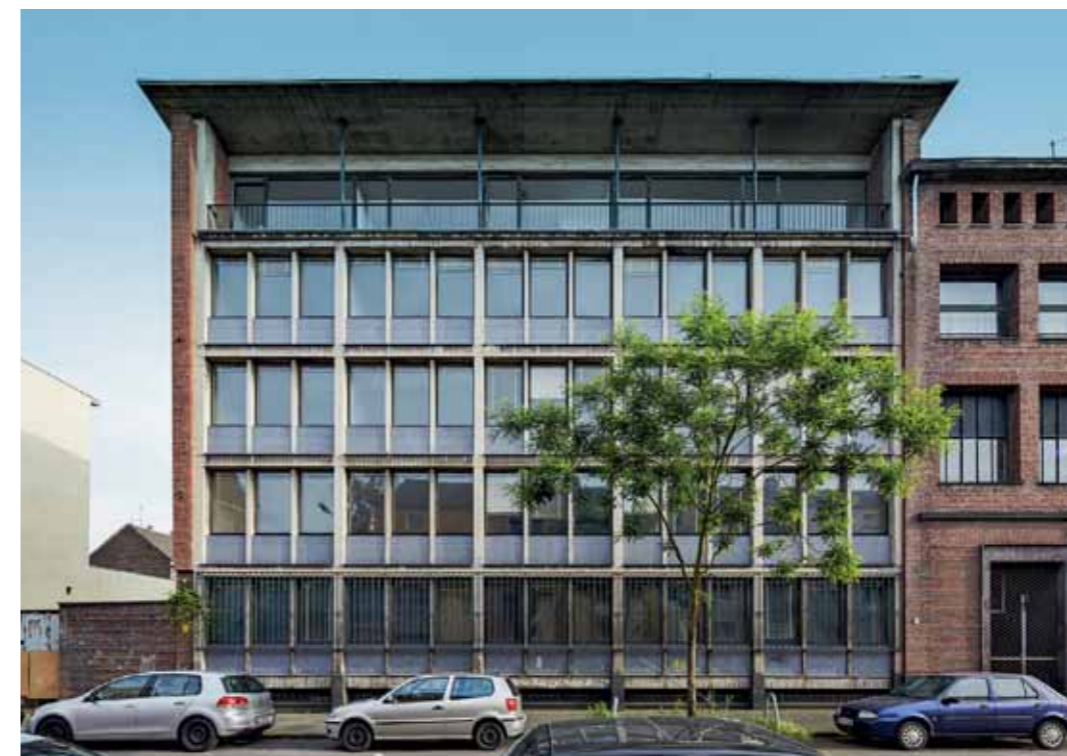
Das ehemalige Verwaltungsgebäude der Samtweberei wurde nach jahrelangem Leerstand als Schrottimobilie gehandelt
