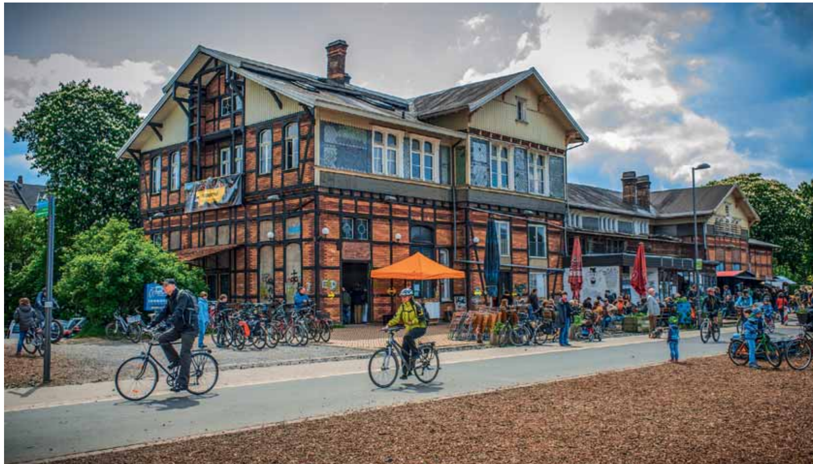
Der Bahnhof Mirke liegt direkt an der Nordbahntrasse, einem 23 Kilometer langen Fuß- und Radweg auf den ehemaligen Gleisen Foto: Sven Pacher
