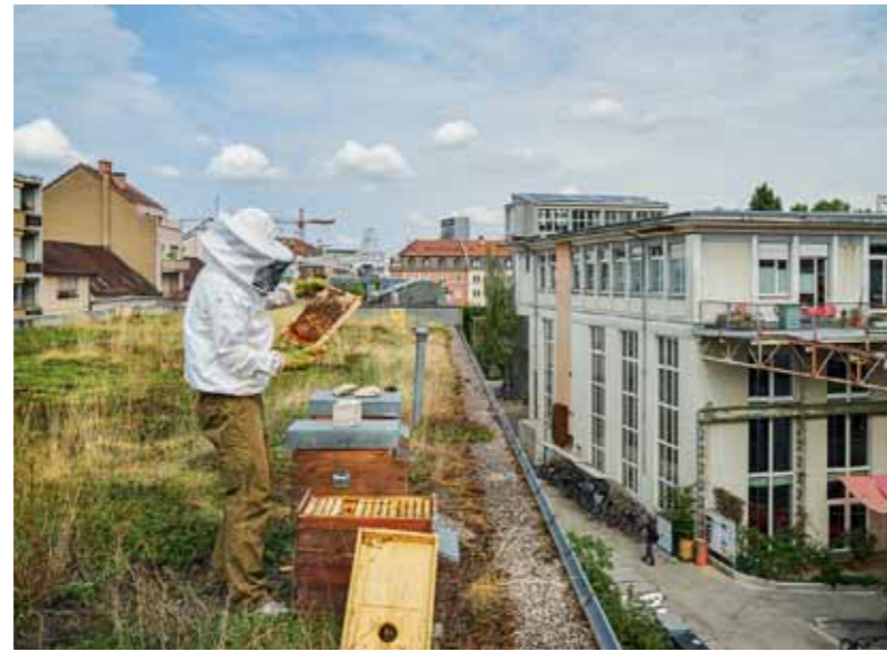
Das 2000-Watt-Quartier hat viele Gesichter: Architektonisch wurden so viele gebrauchte Bauteile wie möglich – aus dem Bestand selbst oder der Bauteilbörse – verwendet; das Gelände wurde intensiv begrünt. Auf dem Dach wird quartiers-eigener Honig produziert
