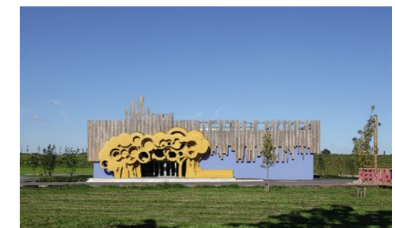
Die Villa – eine Mehrzweckhalle von FAT architecture im Norden von Hoogvliet Foto: Rob Parrish
