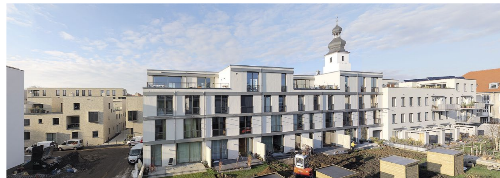
Wohnen nach Wahl in der Baugruppe: hier die „Baufreunde“ Köln
