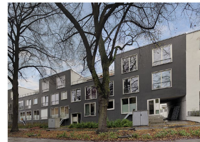
Nach außen gibt sich die Baugruppe mit ihrer dunklen Putzfassade eher verschlossen
