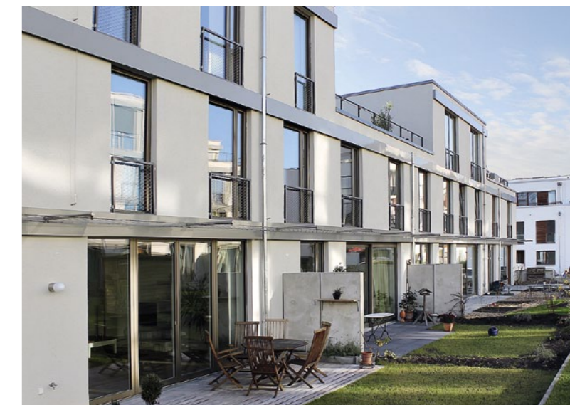
Die Wohnungen öffnen sich zum Innenhof, der in private Gärten unterteilt ist | Fotos: office03
